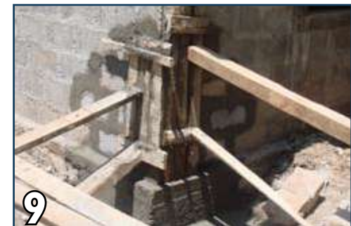
9 Pour 1:2:4 concrete in the columns with proper compaction
