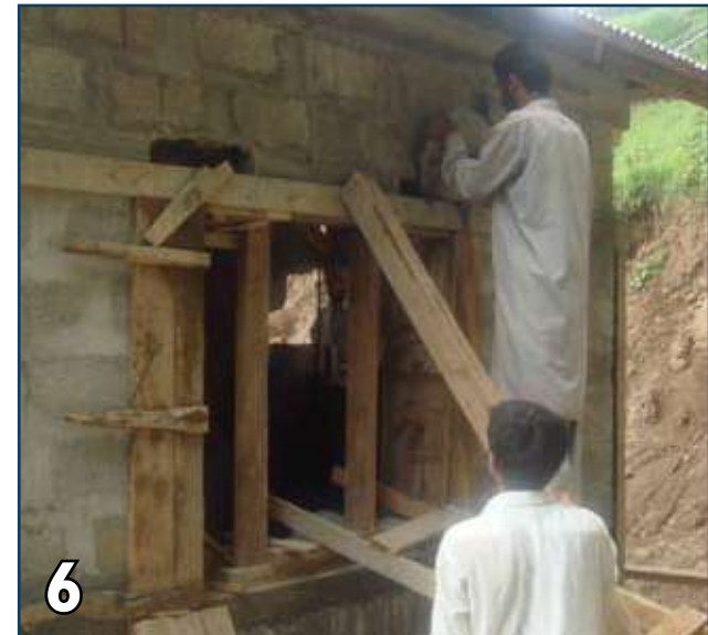
6 Place shuttering and pour concrete.
