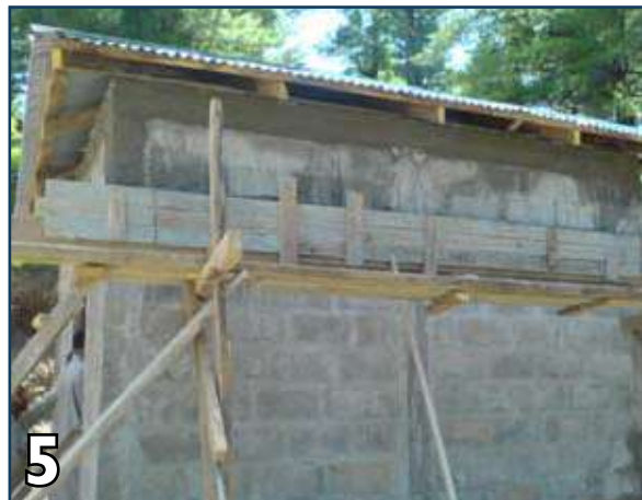
5 Place shuttering and pour concrete.
